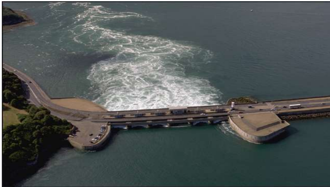
Figura 4. Usina de La Rance, França. 24 turbinas de 10 MW.
